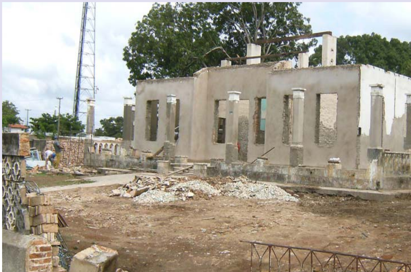
Obra da Vara do Trabalho de Piripiri: instalações modernas em prédio que preserva as características arquitetônicas do século passado
