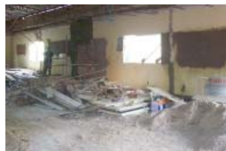
Reforma do Fórum de São Raimundo Nonato
